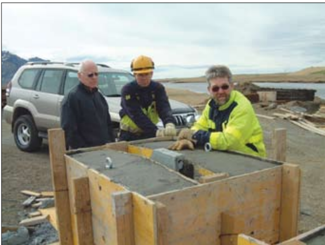
Ankeri sem festir enda víravegriðsins. Á myndinni eru frá vinstri talið: Bjarni H. Johansen rekstrarstjóri í Borgarnesi, Sigurður Hallur Sigurðsson og Guðmundur Sigurðsson brúasmíðir frá Hvammstanga.
